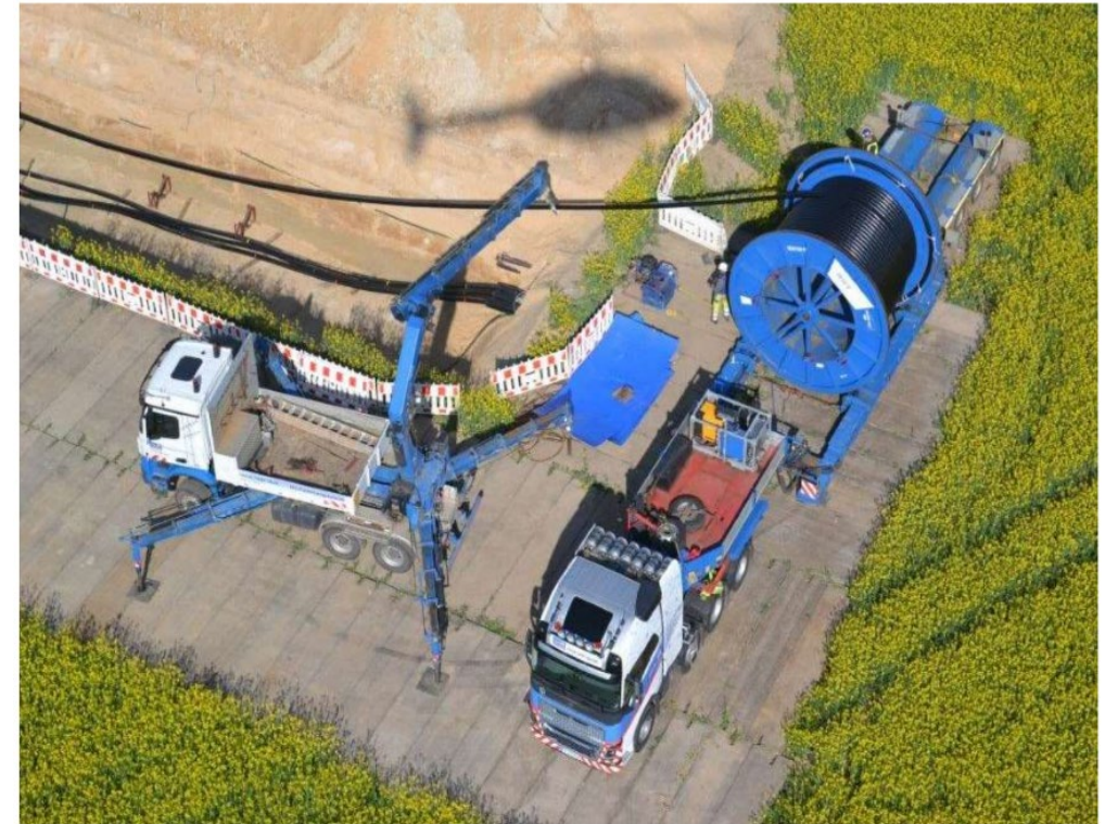
Bildquelle: Prysmian Projects Germany GmbH
