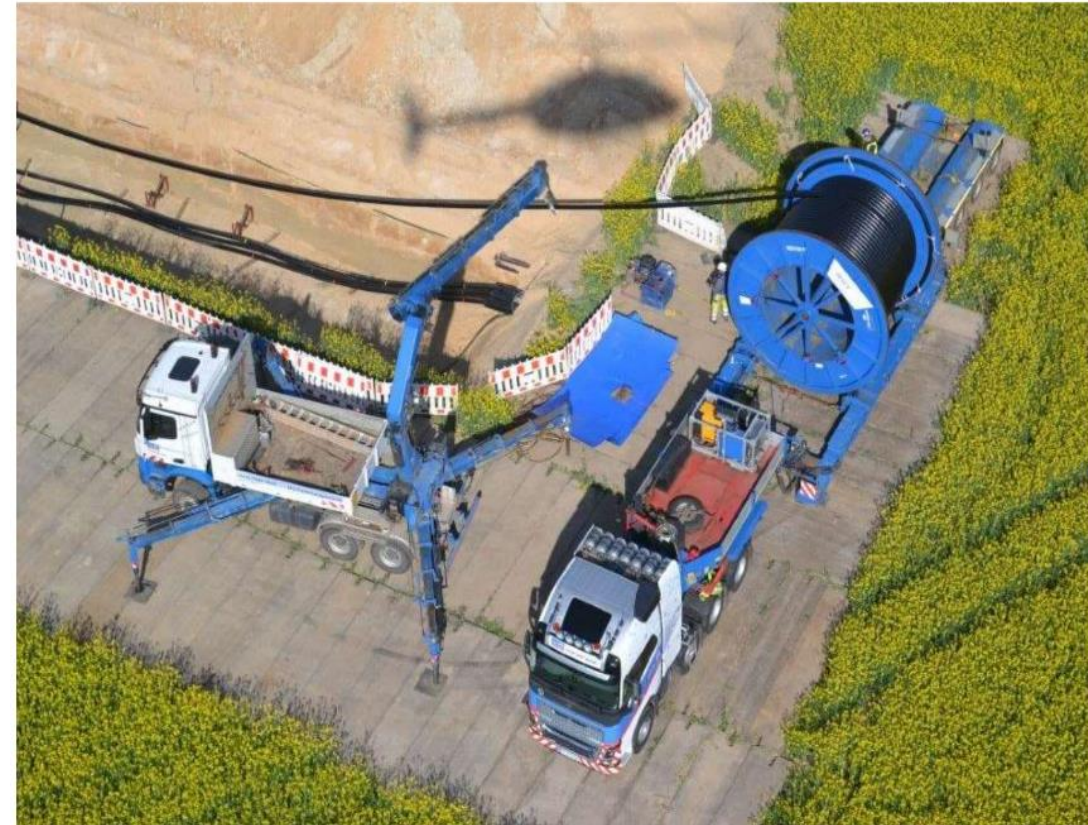
Bildquelle: Prysmian Projects Germany GmbH
