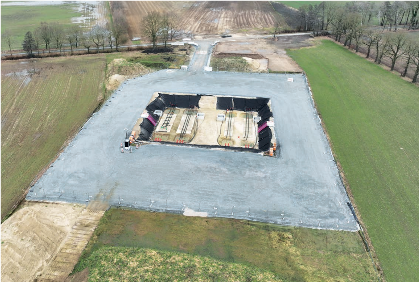
Das Foto zeigt den Kabeleinzug bei dem Gleichstromerkabelprojekt A-Nord. ©Amprion GmbH/IPA A-Nord
