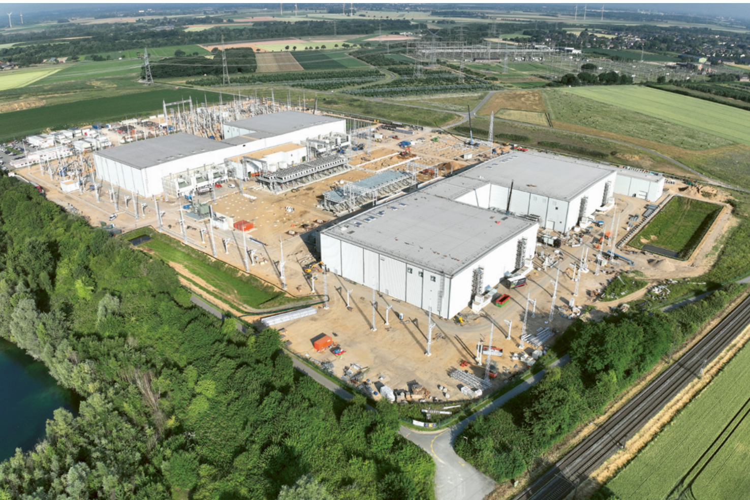
Drohnenaufnahme der im Bau befindlichen Konverterstation des Projekts Ultranet in Meerbusch-Osterath im Juni 2025
