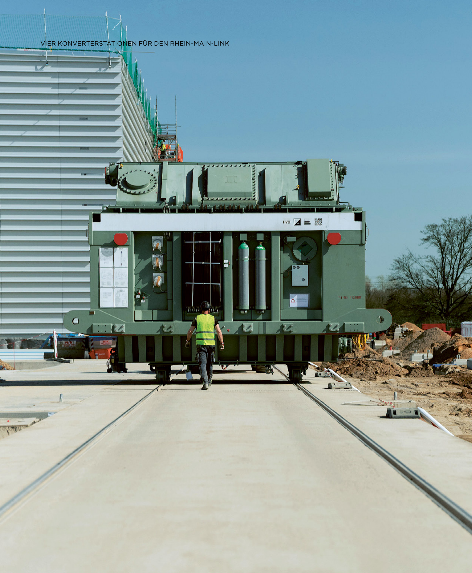
Transport eines Transformators beim Bau der Konverteranlage in Meerbusch-Osterath
