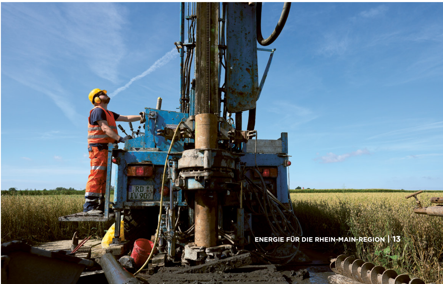
Durchführung einer Bodengrunduntersuchung des Projekts Korridor B
