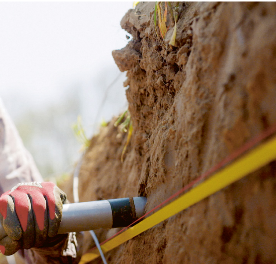
Einbau der Feuchte- und Temperaturmesstechnik bei der Stromverbindung ALEGrO
