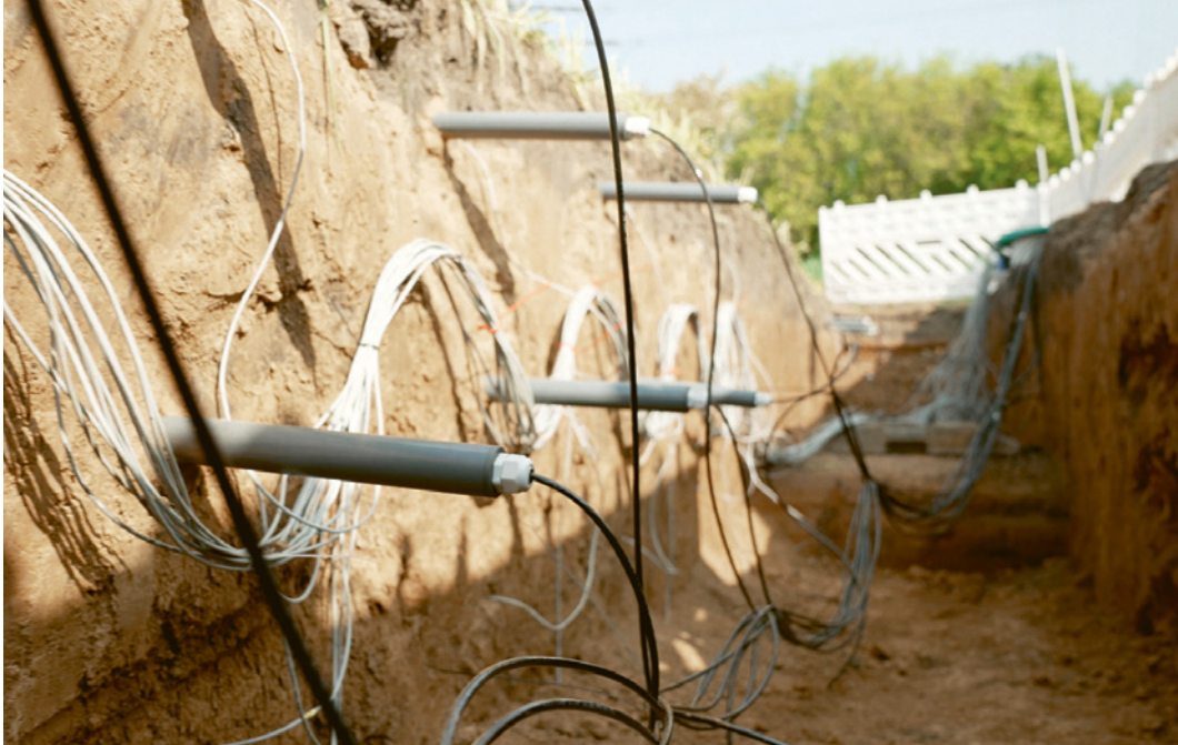
Einbau der Feuchte- und Temperaturmesstechnik bei der Stromverbindung ALEGrO
