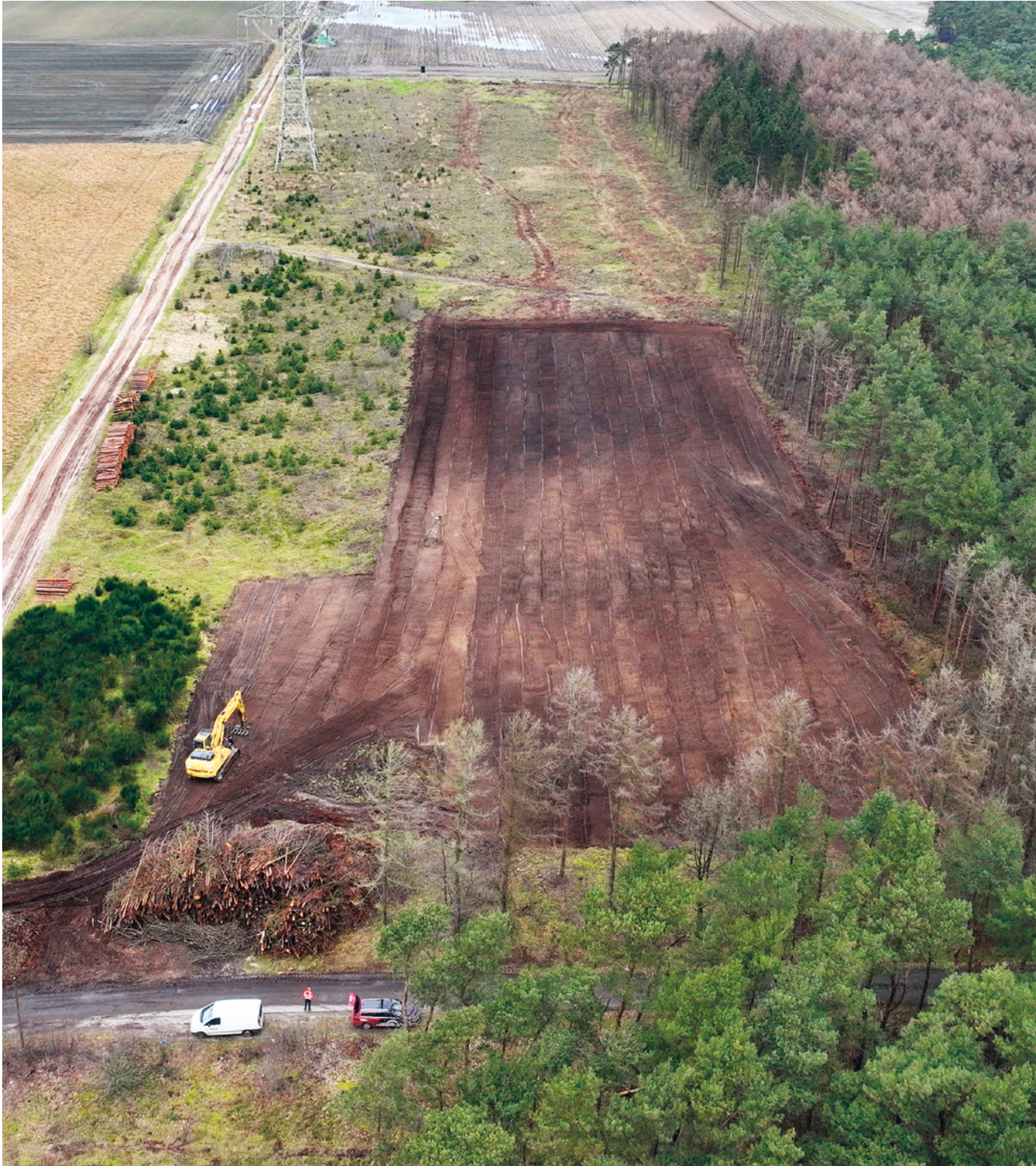
Im Erdkabelprojekt A-Nord kommt die HDD-Bohrung zum Einsatz. Hier wird die Fläche für die Startgrube eingerichtet.
