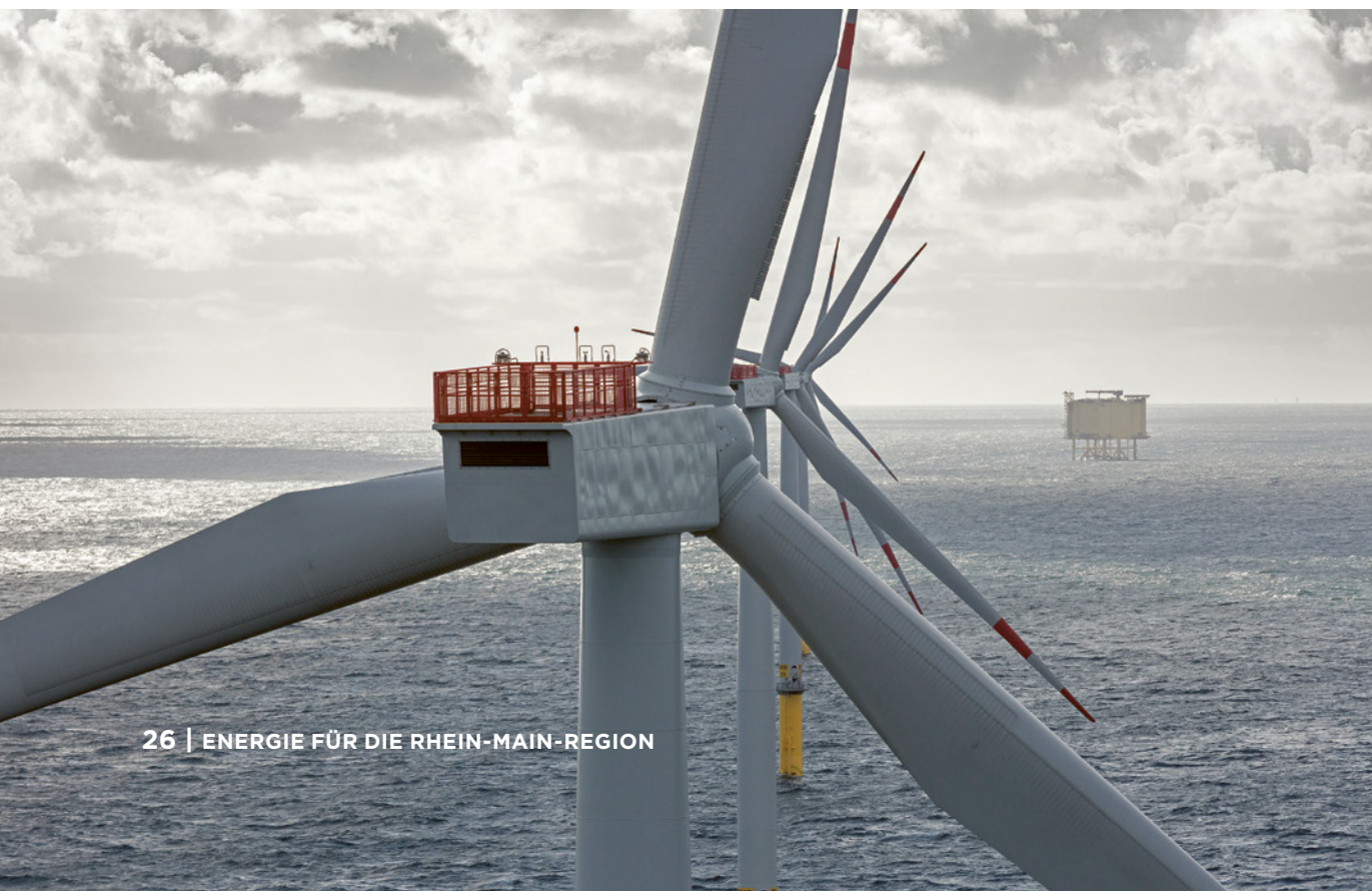
Offshore-Windpark mit Konverterstation im Hintergrund
