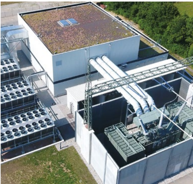
RPSA übernehmen durch ihre schnelle und stufenlose Blindleistungsbereitstellung eine wichtige Rolle bei der dynamischen Spannungshaltung
