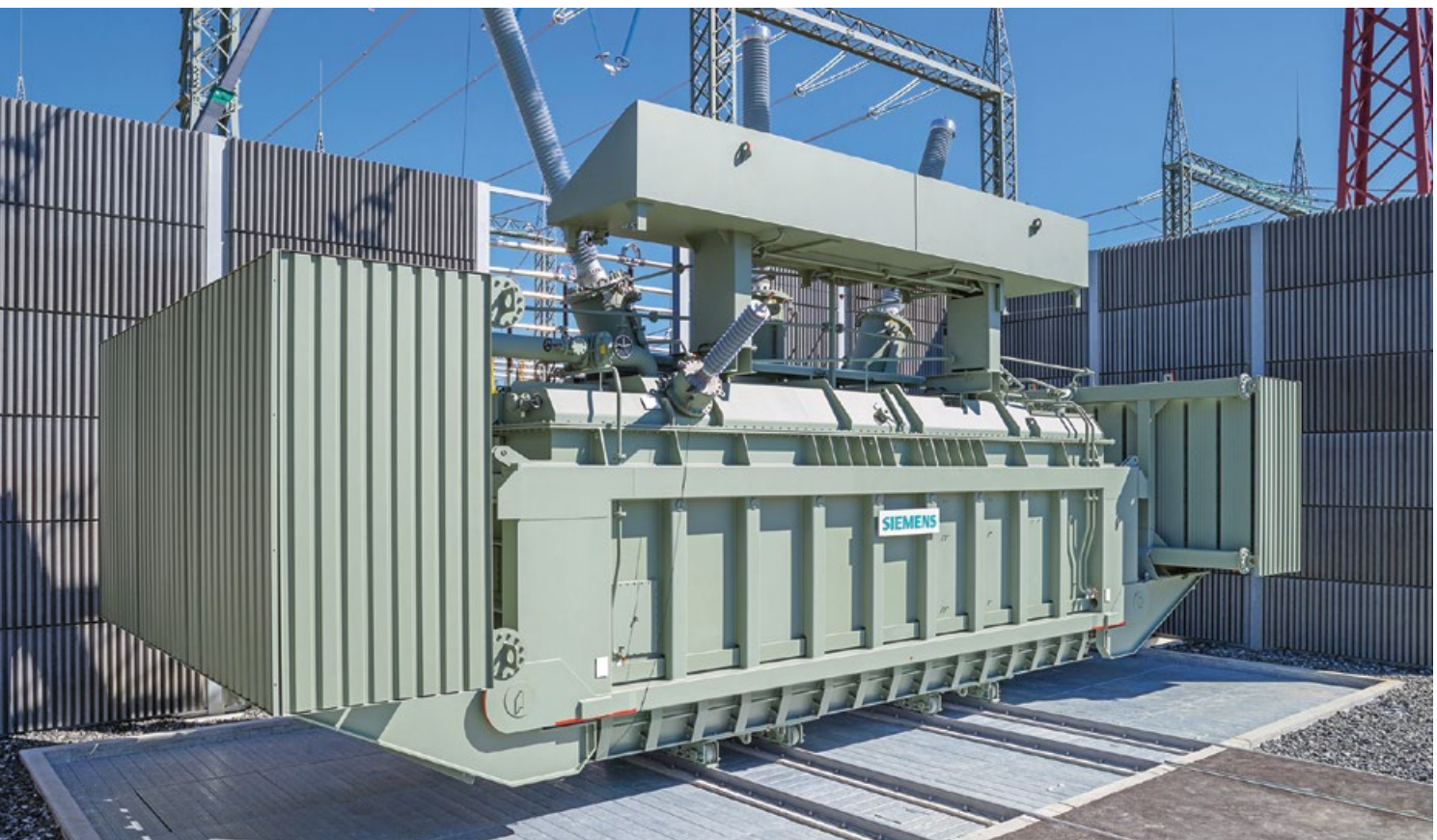
Drosseln kommen dann zum Einsatz, wenn die Spannung zu hoch ist. Mit modernen, regelbaren Drosseln lässt sich die Spannung stufenweise senken.
