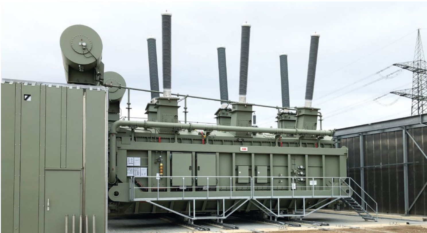
Mithilfe des Phasenschiebertransformators lässt sich der Lastfluss steuern
