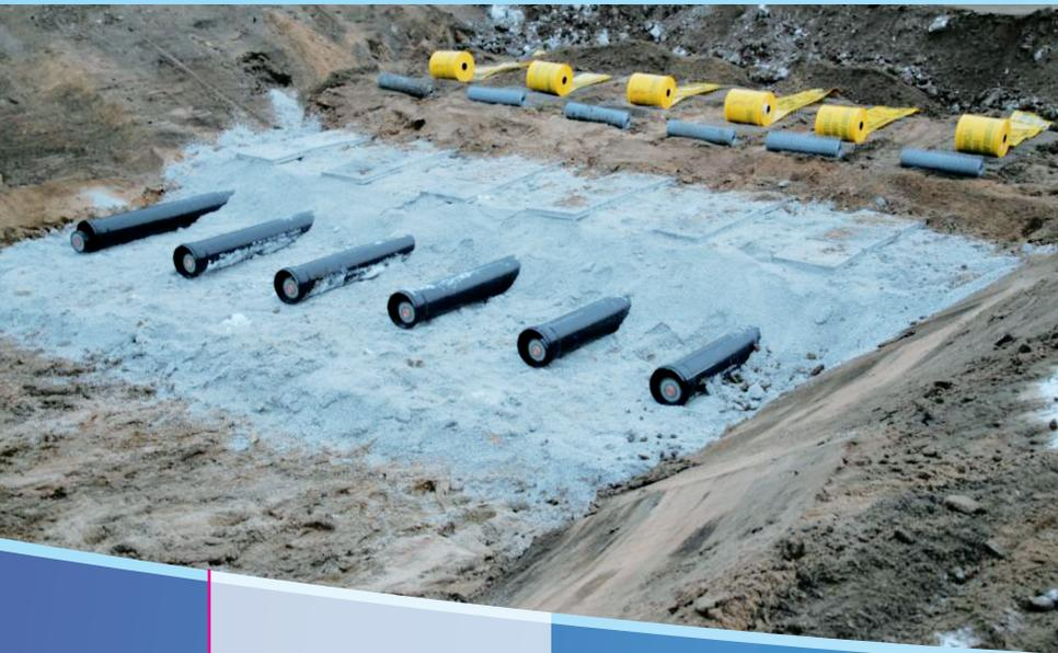
Beispiel eines Kabelgrabens für einen 380-kV-Stromkreis.
