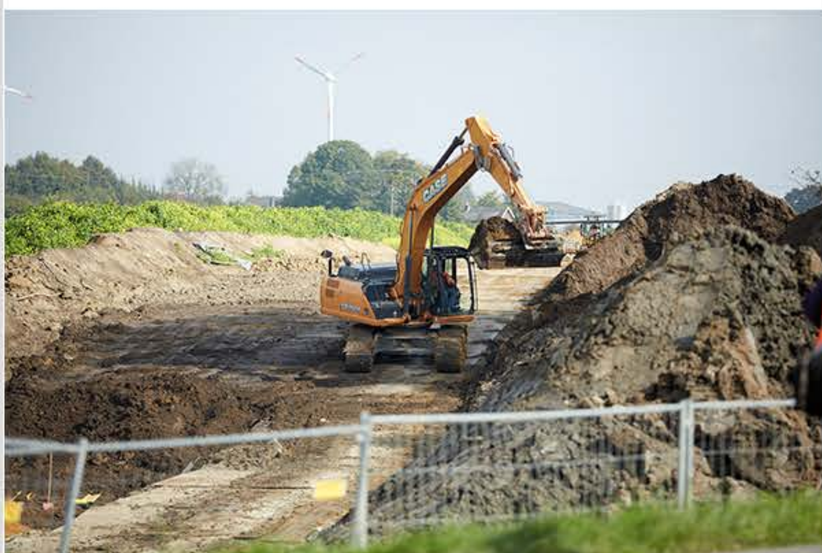
Vergleichbare Erdkabelbaustelle in Raesfeld (Quelle: Amprion GmbH / Frank Peterschröder)
