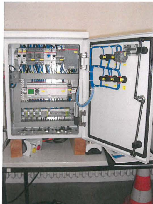
Schaltschrank mit Logikbaustein und Schaltgeräten
