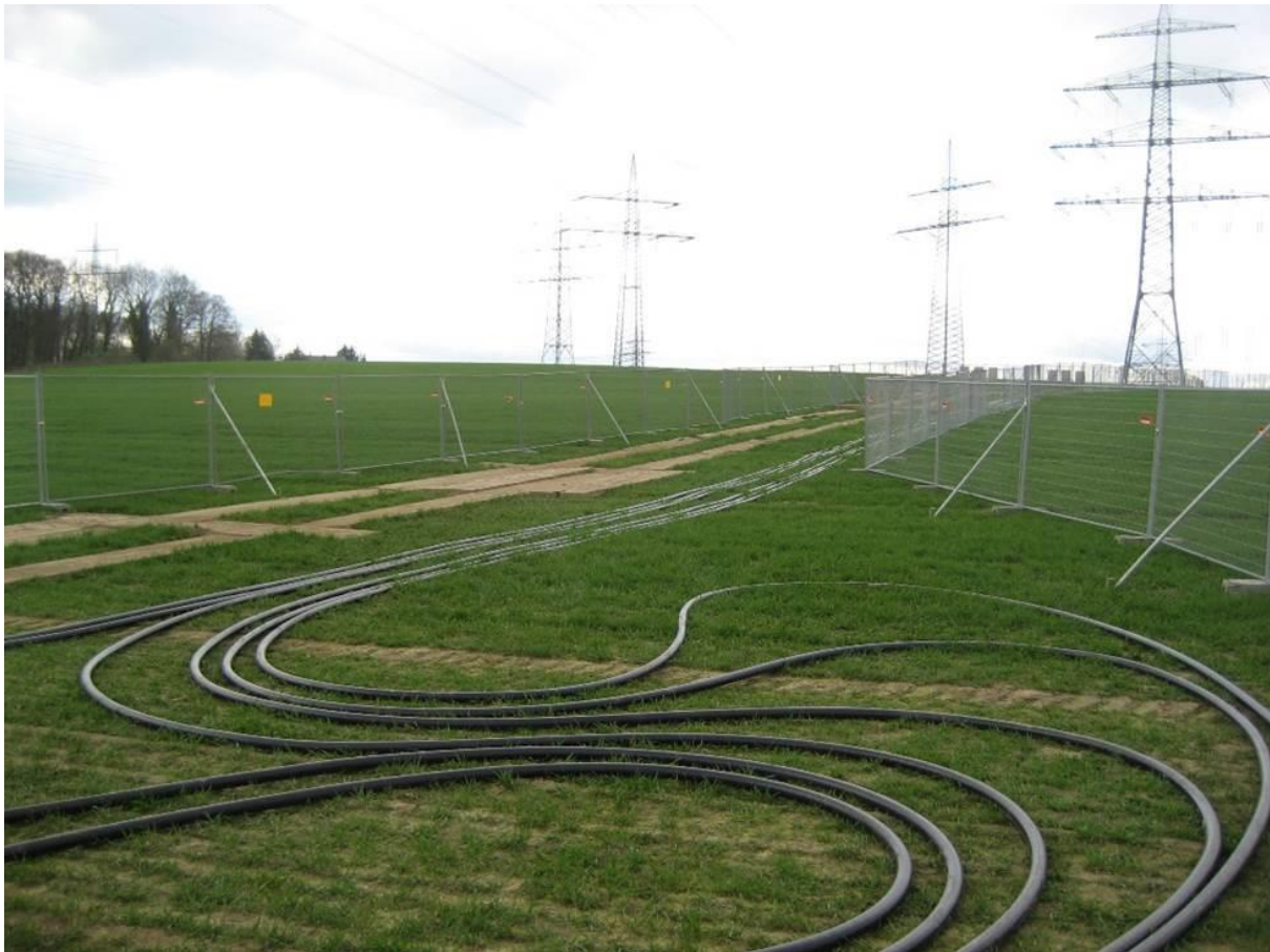
Abbildung 25: Provisorium als Baueinsatzkabel
