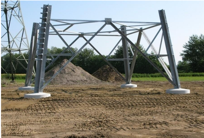
Abbildung 17: Montierter Mastfuß
