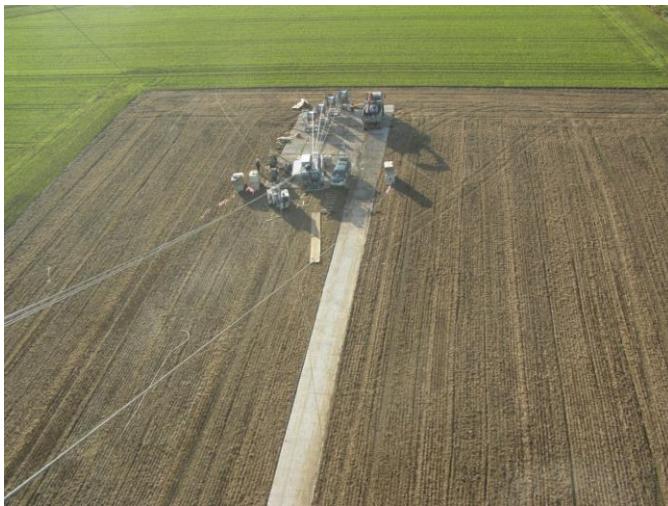
Abbildung 21: Windenplatz eines 4er-Bündel-Seilzuges
