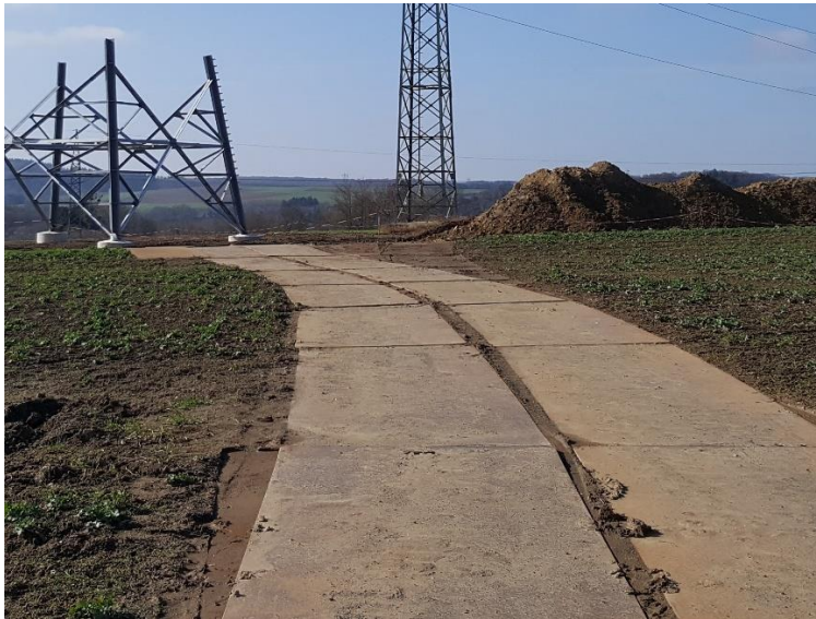
Abbildung 12: Temporäre Zuwegung über Fahrbohlen wie hier mit Stahlplatten
