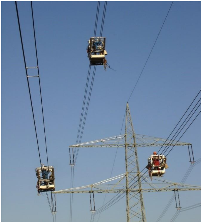
Abbildung 22: Montage der Feldbündelabstandhalter mit Fahrwagen
