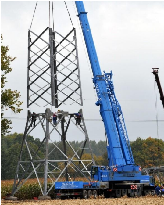
Abbildung 18: Mastmontage (Stocken)
