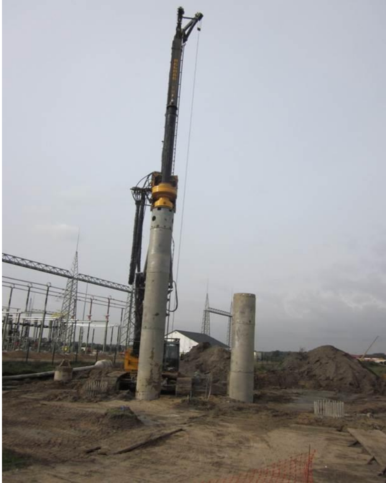
Abbildung 16: Bohrung für einen Bohrpfahl
