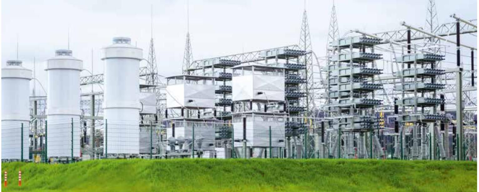
Amprion hat erstmals eine Hybridanlage zur Blindleistungskompensation in Betrieb genommen. In der Umspannanlage Kriftel trägt sie dazu bei, das Spannungsniveau im Netz stabil zu halten.
