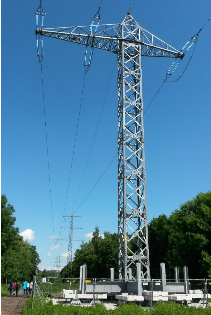
Abbildung 22: Darstellung eines Freileitungsprovisorium
