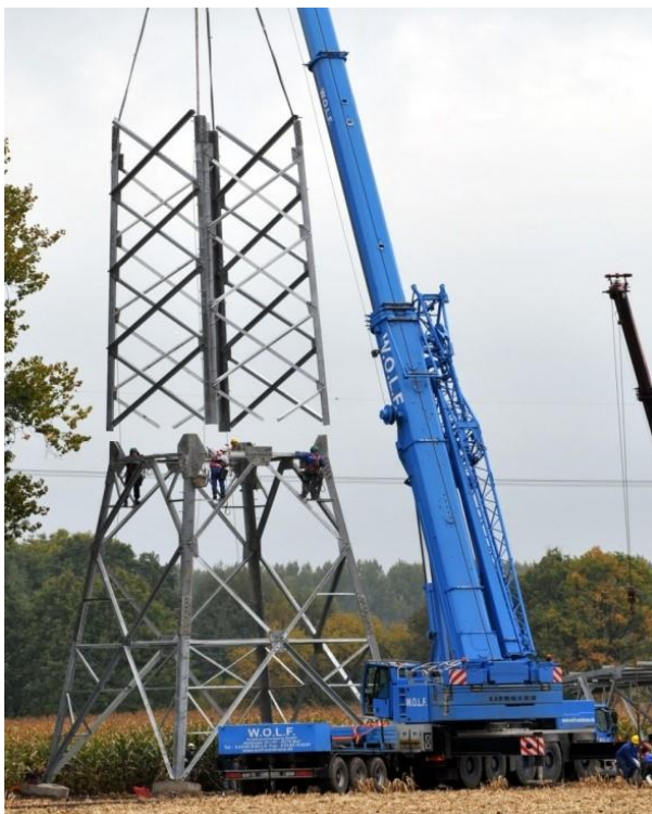
Abbildung 17: Mastmontage (Stocken)
