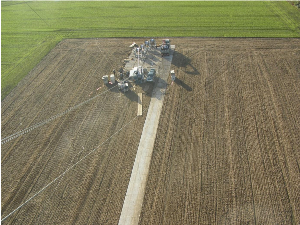
Abbildung 19: Windenplatz eines 4er-Bündel-Seilzuges
