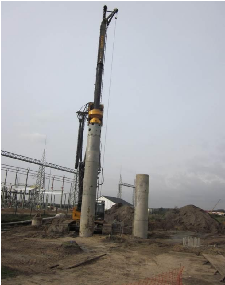
Abbildung 15: Bohrung für einen Bohrpfahl
