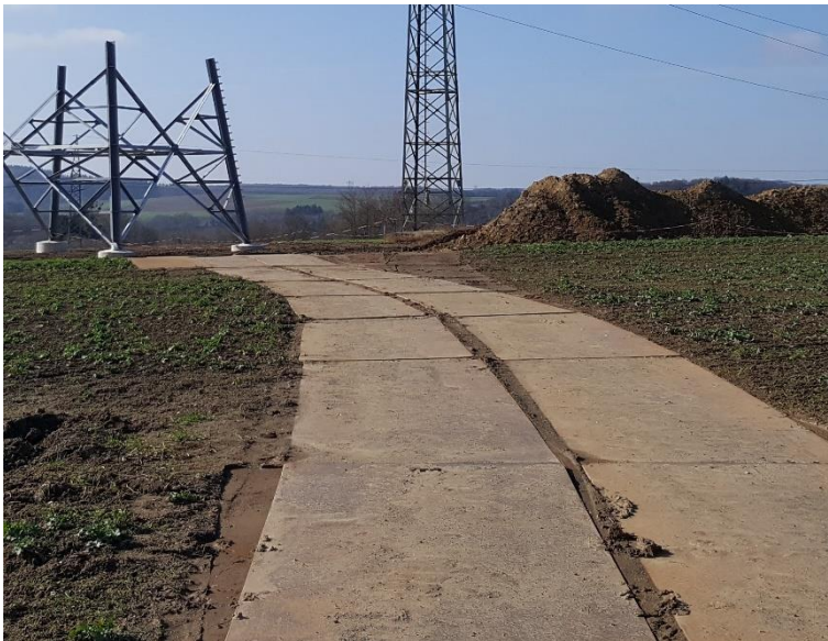
Abbildung 11: Temporärer Wegebau (hier Stahlplatten; alternativ: Fahrbohlen, Aluverbundsysteme)
