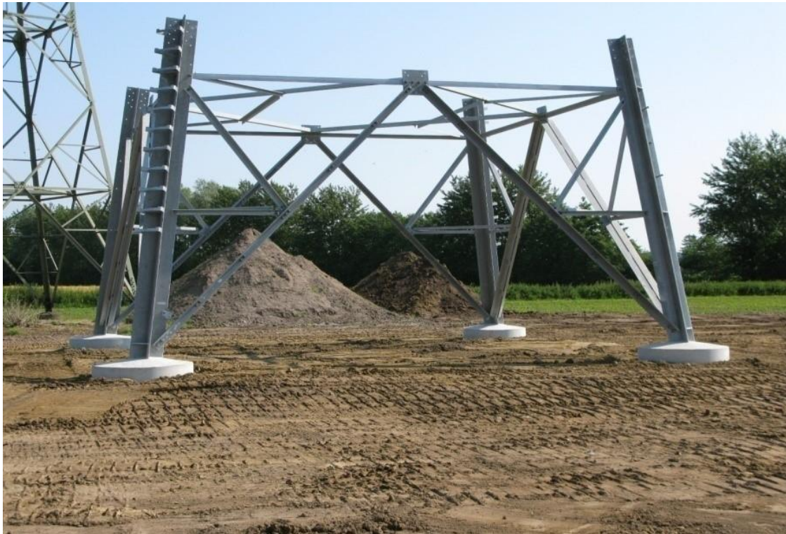
Abbildung 16: Montierter Mastfuß
