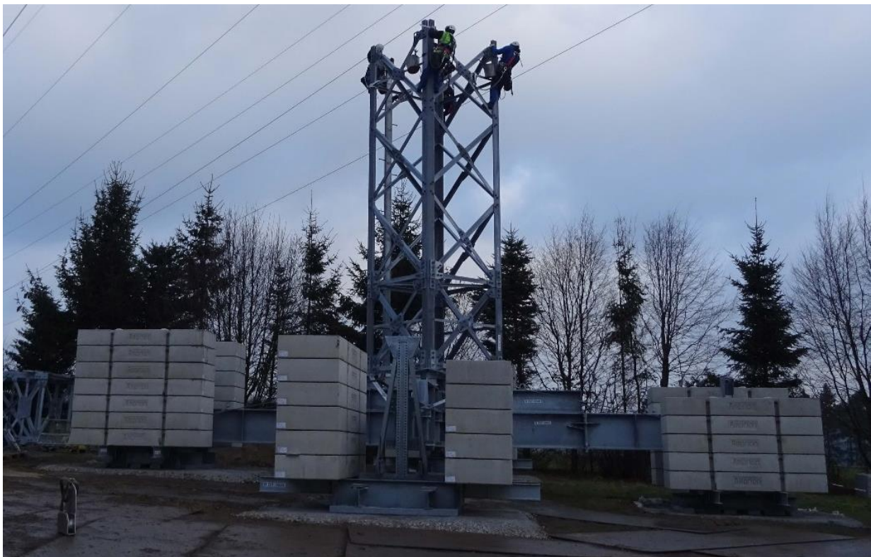
Abbildung 4: Mastfuß eines 380-kV-Provisoriums
