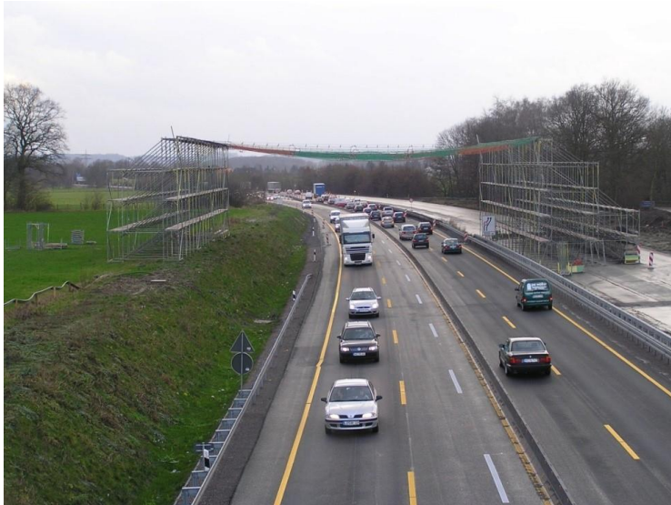
Abbildung 21: Stahlrohrkonstruktion mit Netz zum Schutz über einer Autobahn
