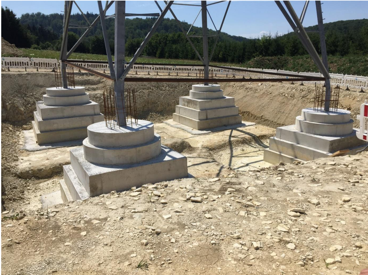
Abbildung 7: Stufenfundament
