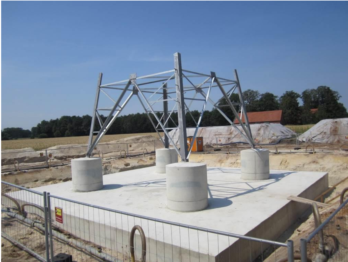
Abbildung 8: Plattenfundament
