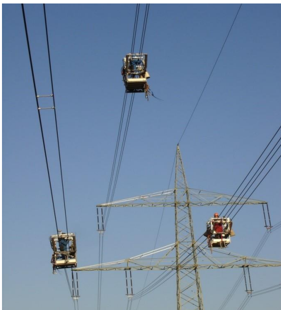
Abbildung 20: Montage der Feldbündelabstandhalter mit Fahrwagen
