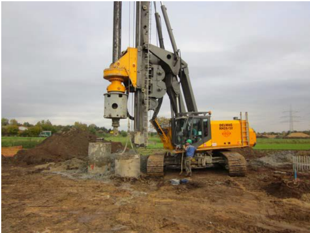
Abbildung 9: Bohrung für einen Bohrspfahl
