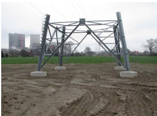
Abbildung 13: Plattenfundament nach der Verfüllung der Baugrube
