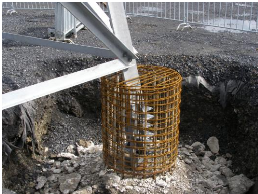
Abbildung 9: Anbindung der Eckpfähle vor dem Betonieren
