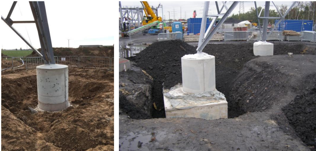
Abbildung 10: Anbindung der Eckpfähle nach dem Betonieren
