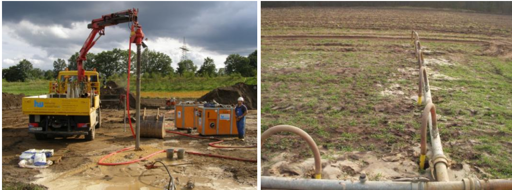
Abbildung 7: Einrichtung der Wasserhaltung mittels Spüllanzen
