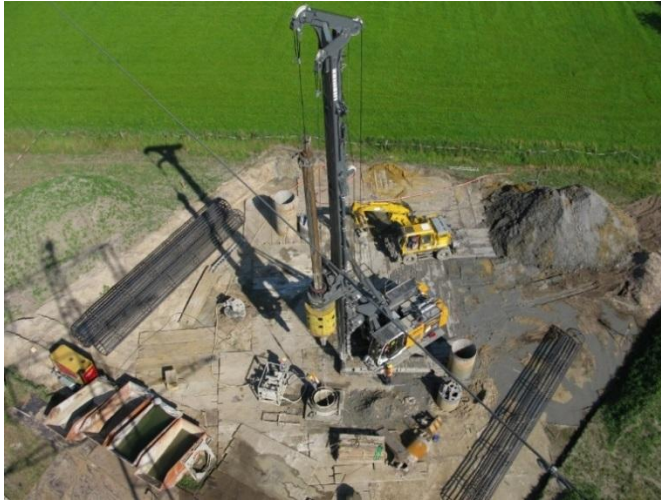
Abbildung 5: Erstellung der Bohrpfähle
