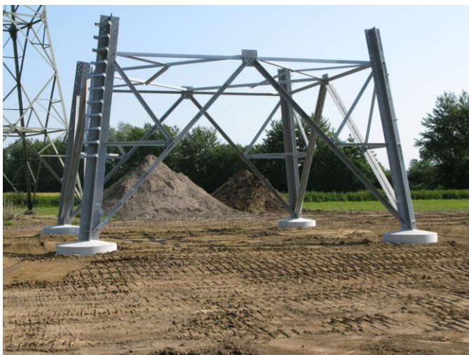
Abbildung 11: Mastfuß nach Errichtung und Anbindung an die Bohrpfähle
