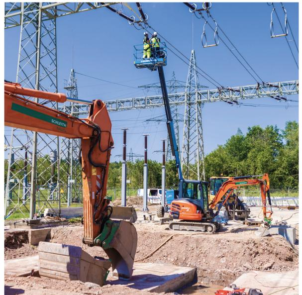
In der 220-kV-Schaltanlage werden moderne Sammelschienen aus Aluminiumrohren gebaut.
