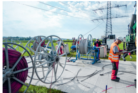
Die Techniker von Amprion planen alle Maßnahmen – im Bild eine Umbeseilung – mit geringstmöglichen Eingriffen für Mensch und Umwelt.
