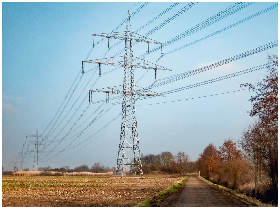
Zurzeit sehen die Masten zwischen den Umspannanlagen Kühmoos und Daxlanden noch aus wie auf diesem Foto. Zukünftig wird auf den freien Gestängeplätzen ein weiterer 380-kV-Stromkreis der Amprion GmbH zubeseilt. Dann sieht die rechte Mastseite wie die linke aus.
