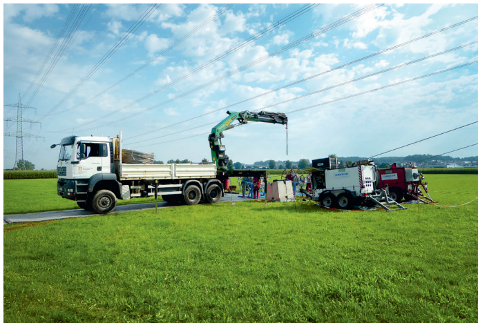
Die Techniker von Amprion planen alle Maßnahmen – im Bild eine Umbeseilung – mit geringstmöglichen Eingriffen für Mensch und Umwelt.
