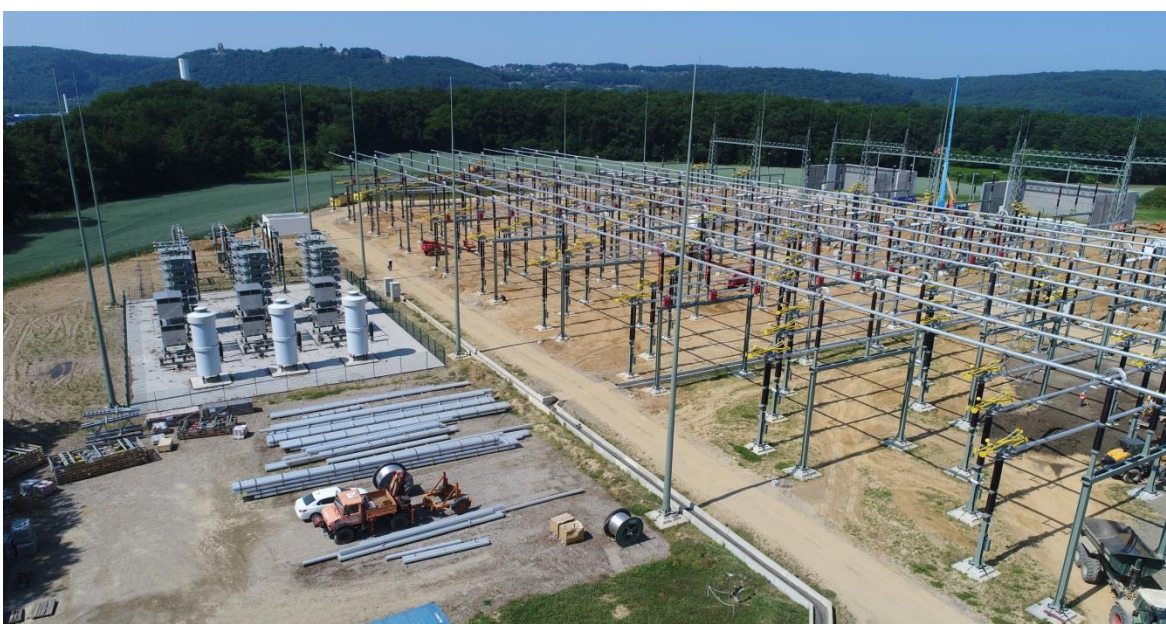
Abb. 2: Nahaufnahme der im Bau befindlichen Umspannanlage Garenfeld
