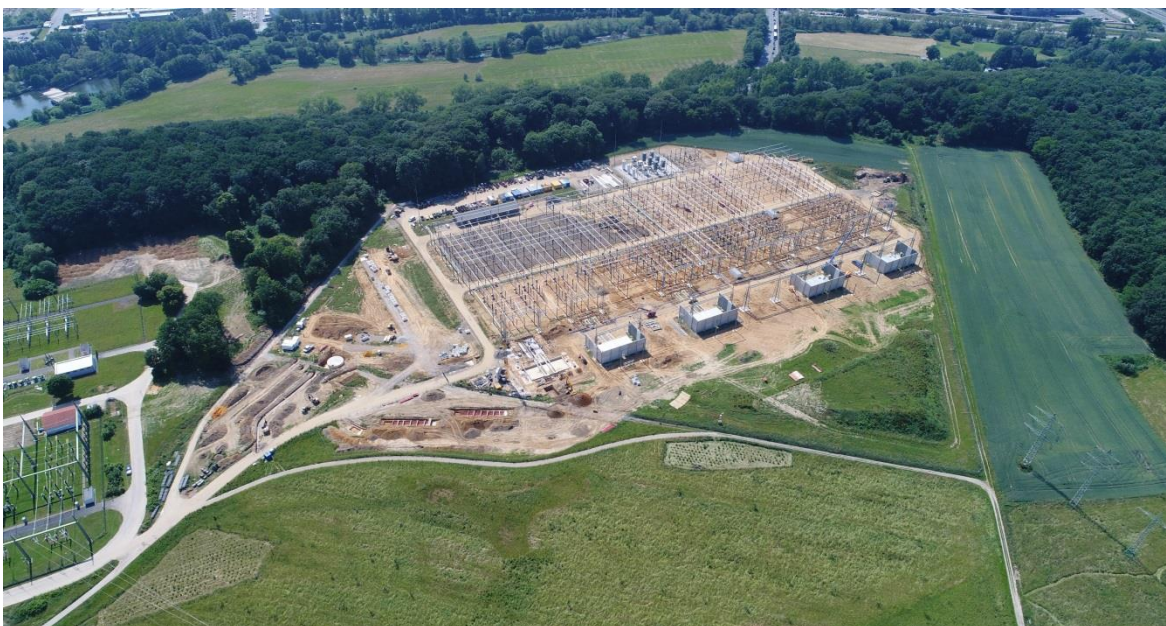
Abb. 1: Luftbildaufnahme der im Bau befindlichen Umspannanlage Garenfeld
