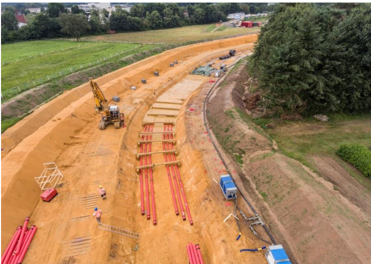
Abb. 1: Kabelgräben Raesfeld (bei Münster), Breite der Baustelle: 45 Meter
