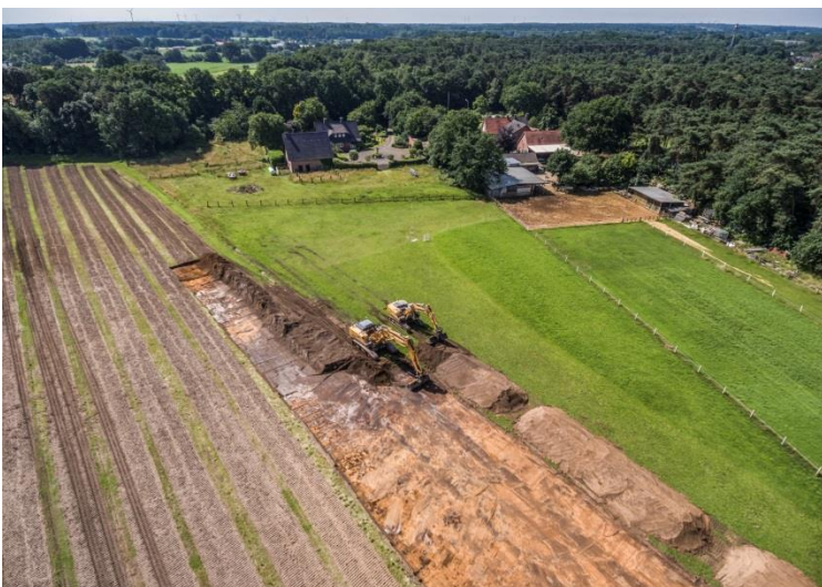
Abb. 3: Abtragung der verschiedenen Bodenschichten
