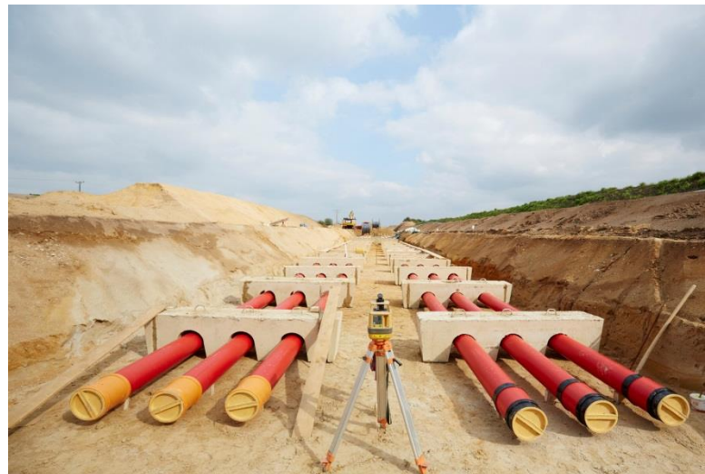
Abb. 2: Schutzrohre in einem von insgesamt zwei erforderlichen Kabelgräben
