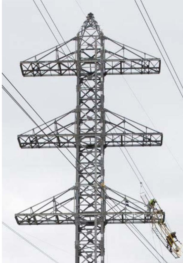
Abbildung 15: Auflastprovisorium (Tonnenanordnung)
