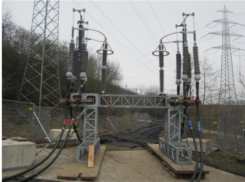
Abbildung 19: Anschluss-/Verbindungselement für Baueinsatzkabel
