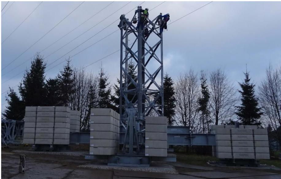
Abbildung 16: Mastfuß der 110-kV und 220-kV-Provisorien
