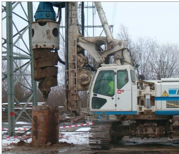
Abbildung 10: Bohrung für einen Bohrpfahl (Quelle: Amprion GmbH)
