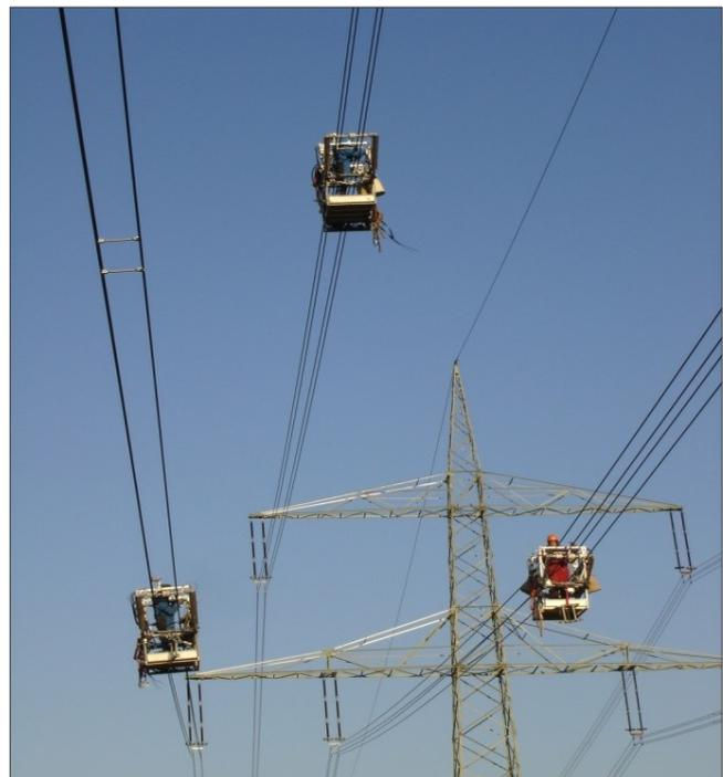
Abbildung 7: Montage der Feldbündelabstandhalter mit Fahrwagen (Quelle: Amprion GmbH)
