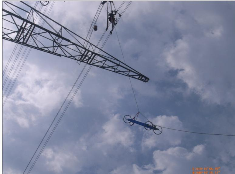
Abbildung 4: Austausch der Isolatorketten (Quelle: Amprion GmbH)
