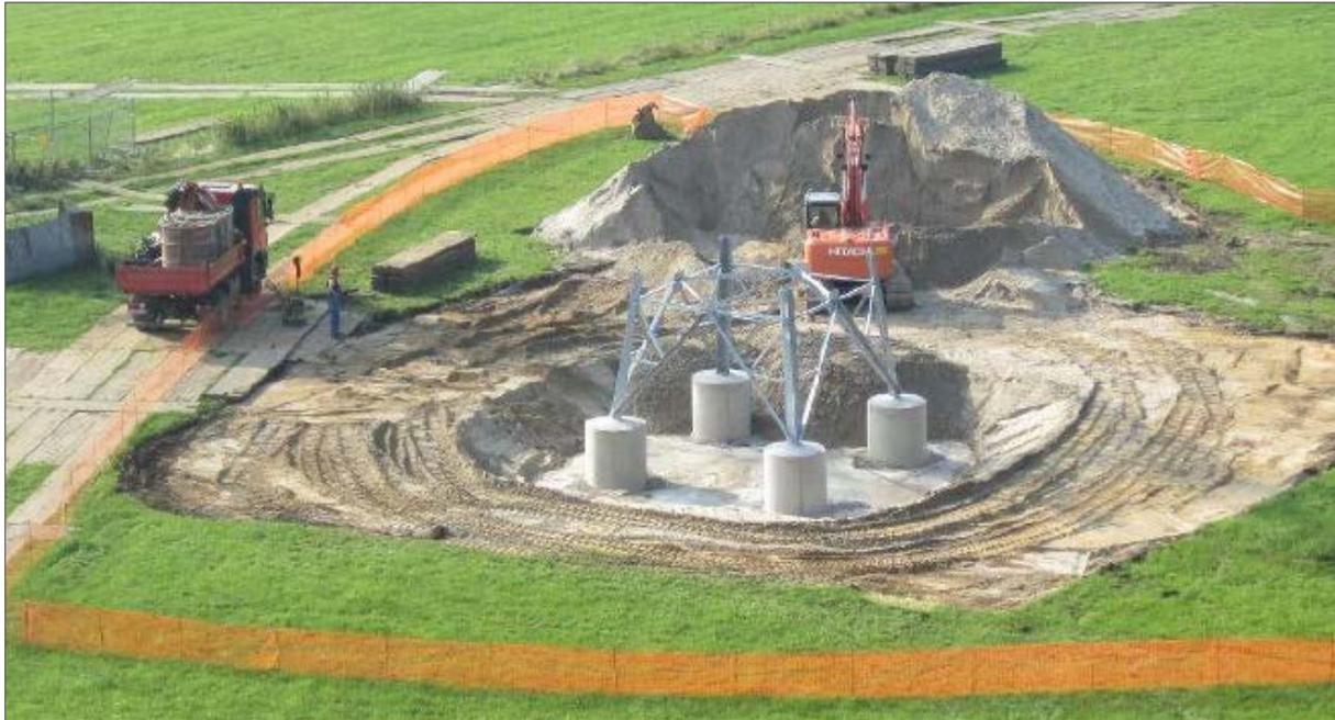
Abbildung 9: Gründung eines Plattenfundaments (Quelle: Amprion GmbH)
