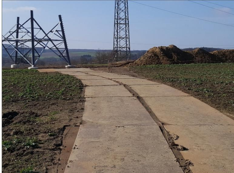
Abbildung 2: Temporäre Baustellenzuwegung über Lastverteilplatten (Quelle: Amprion GmbH)
