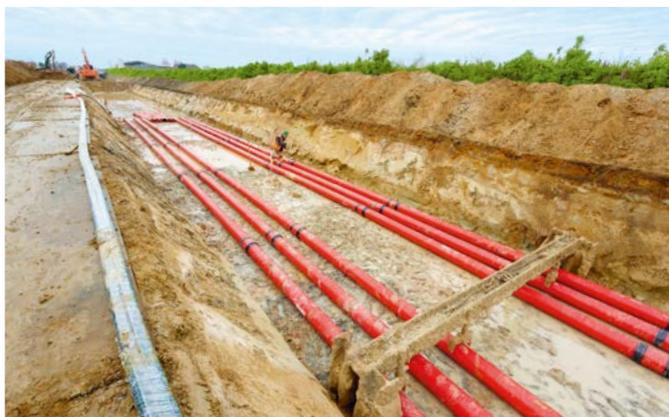
Vergleichbare Wanderbaustelle beim Erdkabel-Pilotprojekt in Raesfeld: Auch die zwei ALEGrO-Kabel werden in Rohre eingezogen. Die Grabensohle für die zwei Kabel ist bei ALEGrO mit anderthalb Metern anstatt fünf Metern jedoch deutlich schmaler.
