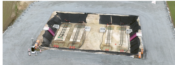
Abbildung 3 Muffengrube mit Schächten, Bodenplatten und Erdkabeln
