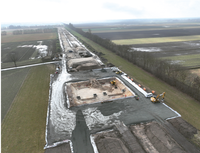
Abbildung 1 Geöffnete Muffengrube mit Schächten, noch ohne Bodenplatten
