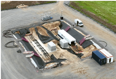
Abbildung 4 Herstellung der Muffe im Jointing-Container
