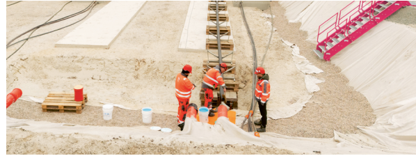
Abbildung 2 Kabeleinzug an einer Muffengrube
