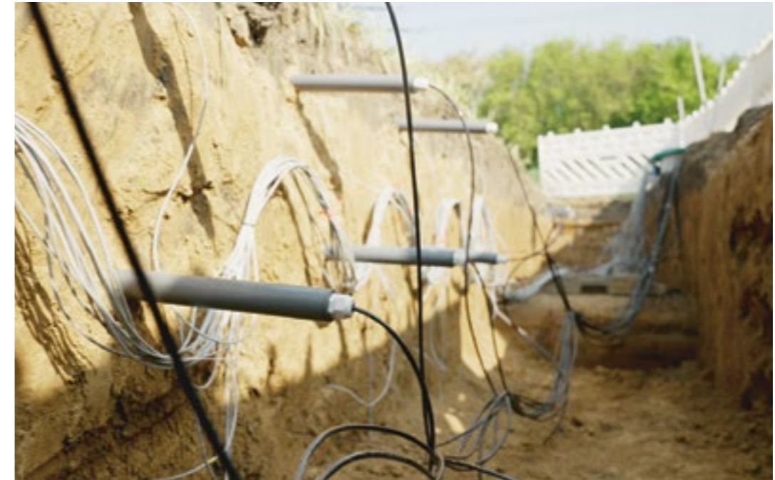
Einbau der Feuchte- und Temperaturmesstechnik bei der Stromverbindung ALEGrO
