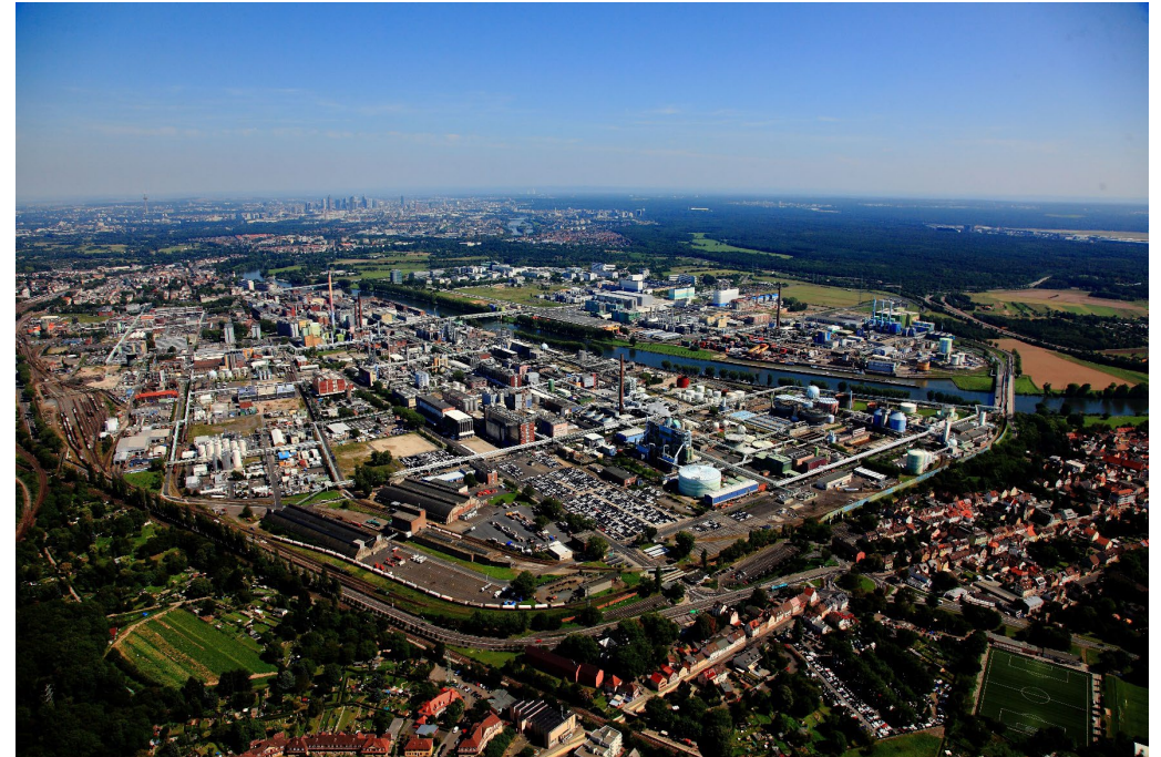
Quelle: InfraserV GmbH & Co. Höchst KG
