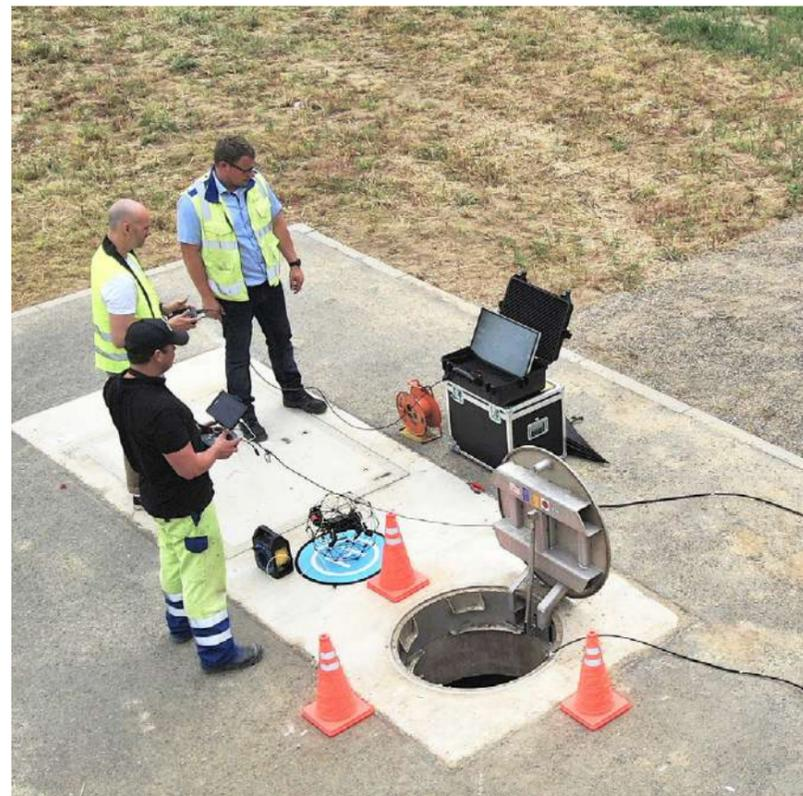
**ABB. 41** Inspektion eines 15 Meter tiefen Kabelschachtes mit einer Indoor-Käfigdrohne
