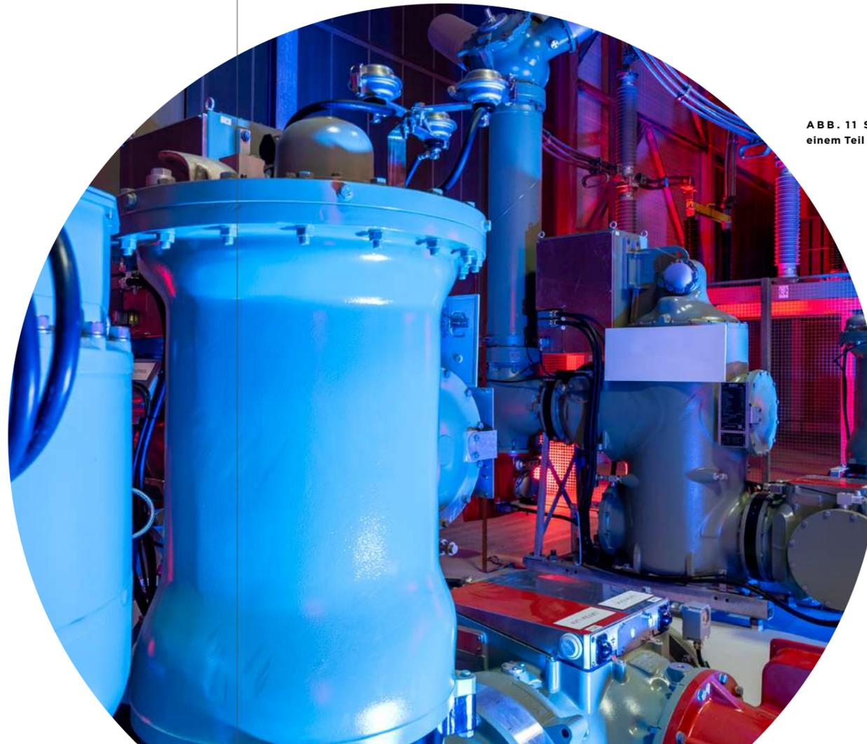
ABB. 11 STATCOM in Rheinau mit einem Teil der gasisolierten Schaltanlage
