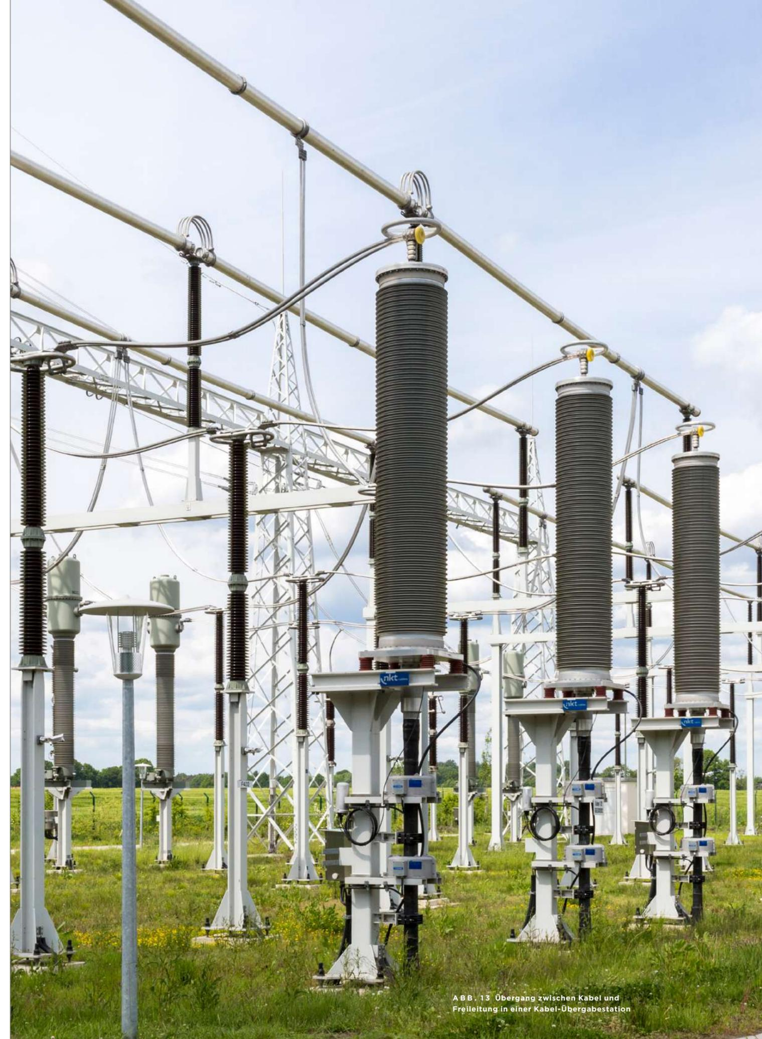
ABB. 13 Übergang zwischen Kabel und Freileitung in einer Kabel-Übergabestation
