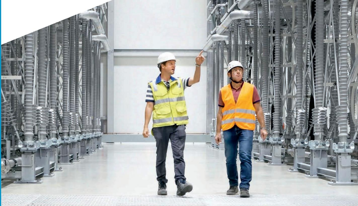
Zur deutsch-belgischen Strombrücke „ALEGrO“ gehören sogenannte Konverter. Diese Hightech-Anlagen wandeln Wechselstrom zu Transportzwecken in Gleichstrom um und am Ende wieder in Wechselstrom zurück. Konverter spielen auch für den Transport von Strom aus Offshore-Windparks ans Festland eine wichtige Rolle. Dafür plant Amprion eigene Plattformen in der Nordsee.
