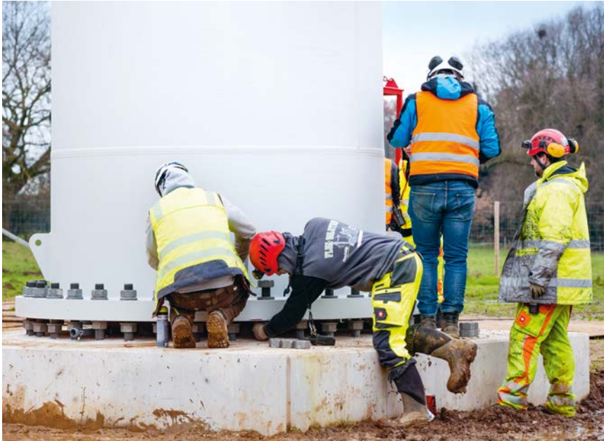
Sicherer Halt: 60 Ankerbolzen fixieren den Mastschaft im Betonfundament.
