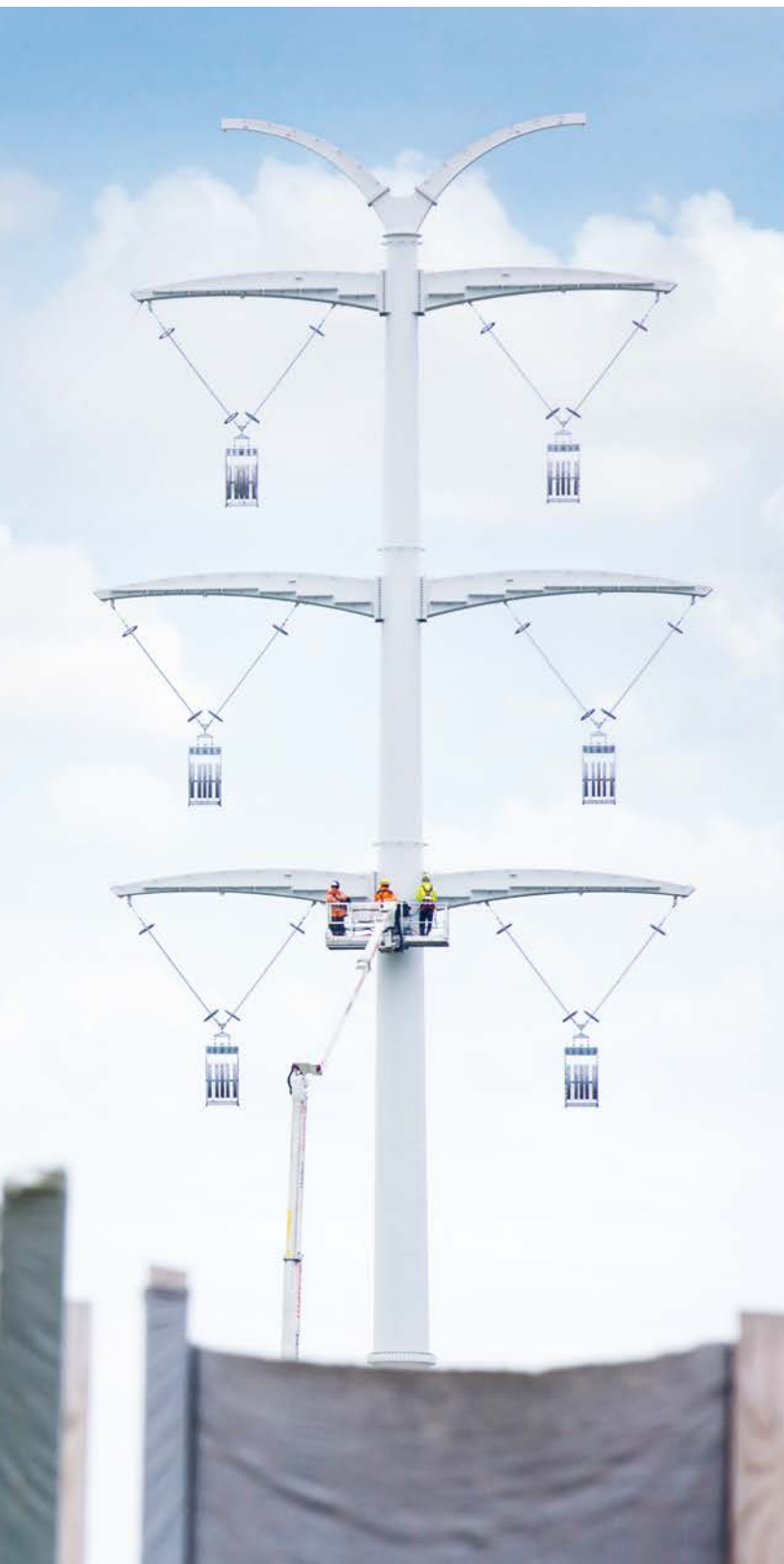
Neuartiges Design: Zwischen der Umspann- anlage Millingen und der niederländischen Grenze testet Amprion einen neuen Masttyp.
