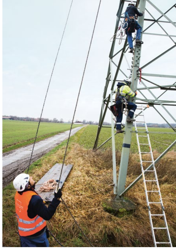
Auf geht's! Auf dem Amprion-Mast Nummer 133 wird eine Nisthilfe befestigt.
