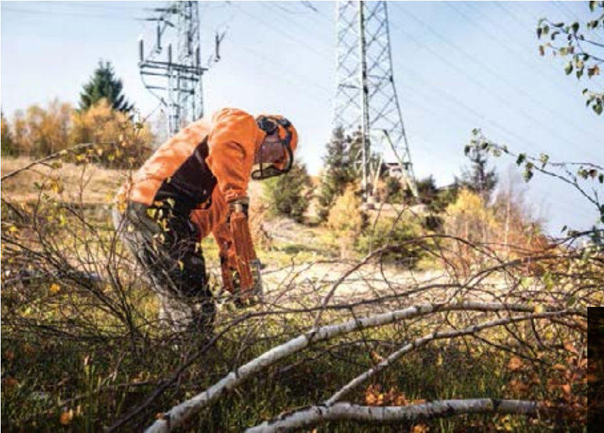
Schutz für die Stromleitungen: Wo sich Äste zur Trasse neigen, werden sie gekappt. Ein Teil des Grünschnitts bleibt im Wald. „So gelangen die Nährstoffe zurück in den Boden“, sagt Amprion-Biotopmanager Matthias Spielmann.
